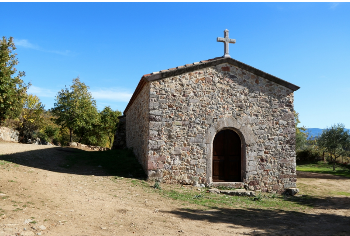
Chiesa di S. Giacomo, Sorgono, facciata (foto M. Cillara, 2017).
