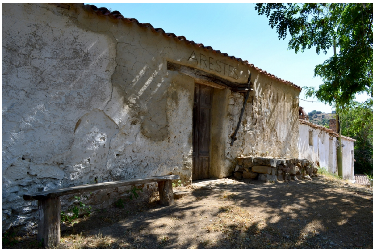
Santuario di S. Mauro, Sorgono, particolare dei “muri stènes” (foto D. Muru, 2017).
